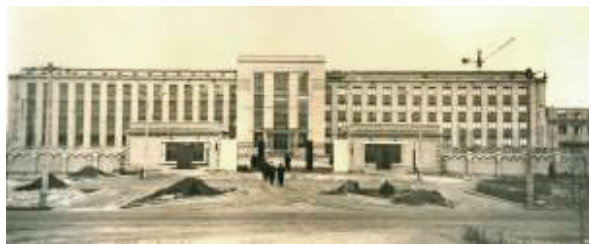
Инженерный корпус ДНИХТИ зд.40 (1970год)
